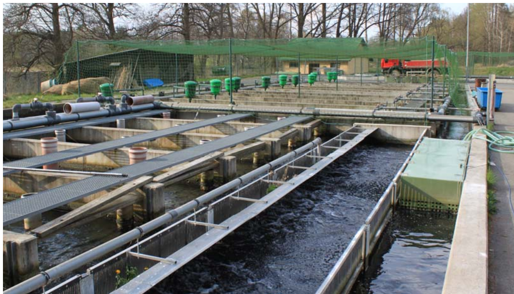
Horizontální RAS Dánského typu v Pravíkově. Tato technologie byla navržena pro stabilnější přímořské klima jižní Skandinávie. Ve vnitrozemí je výhodnější je provozovat v uzavřených halách, které zajistí stabilní teplotní režim v zimě a létě.
